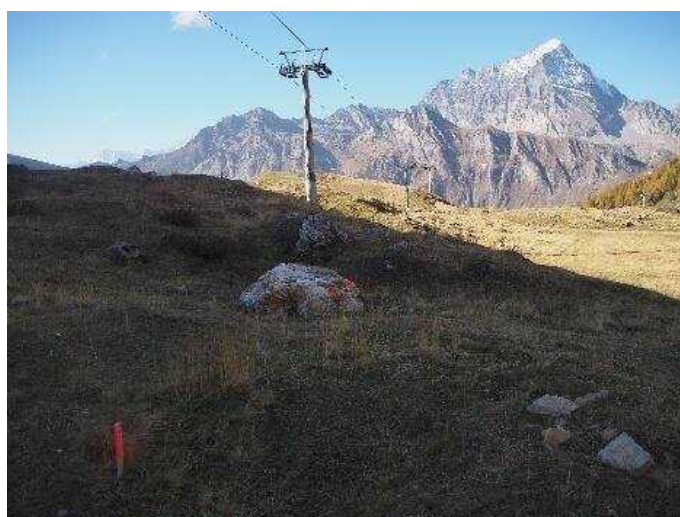
Operazioni di tracciamento topografico del coronamento dell'invaso in progetto.
